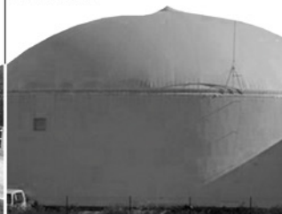
Centrale biomasse Avezzano AQ
